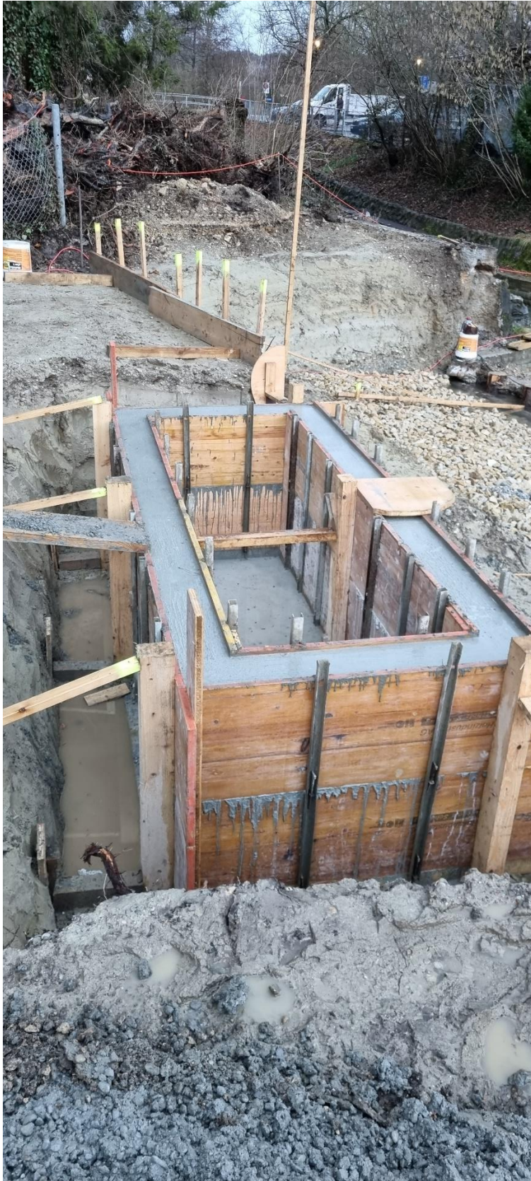
Foto 7: Betonierarbeiten Wände Biberbau
