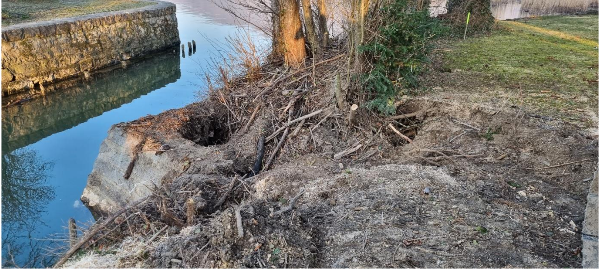
Foto 9: Demontage alter Biberbau unter Aufsicht des Wildhüters.
