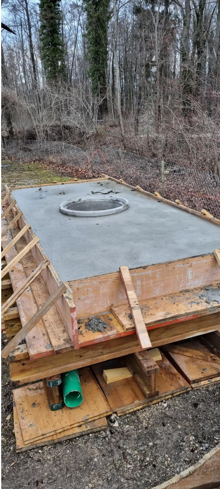
Foto 8: Betonierte Decke Biberbau mit Einstieg -> nachträglich auf Biberbau aufgesetzt.
