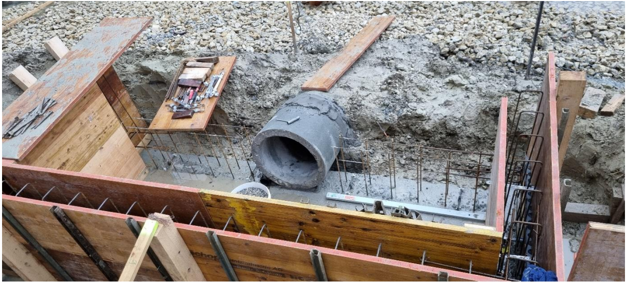
Foto 5: Bodenplatte und Bewehrung Wände Biberbau
